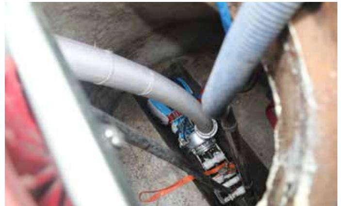
Der an beiden Enden verschlossene Schlauch wird mit Luftdruck an die Kanalwände angepresst (Bild rechts oben).
